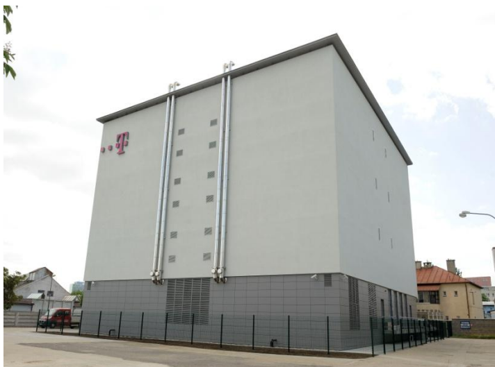
DC Telekom BA-Varšavská
